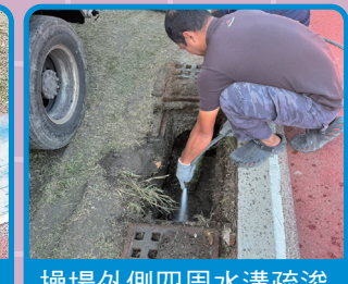
操場外側四周水溝疏浚
